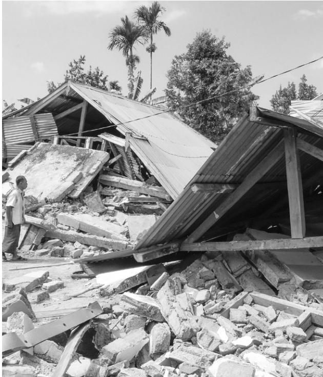
Impacto provocado por el terremoto en Lombok, Indonesia.
